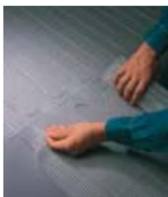
Zweite Schicht Fliesenkleber ca. 5-6 mm gleichmäßig auf ThermoNetz® 2000 verteilen. Fliesen verlegen. Heizung einschalten !
