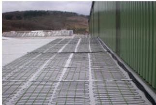
ThermoNetz® Freiflächen-Heizelemente eignen sich für alle Einbettungsarten, wie Sand, Beton, unter Pflastersteinen und auch für die Einbettung in Heiasphalt. Die Heizelemente werden anschluffertig geliefert. In handlichen Rollen verpackt, garantieren sie eine leichte und unkomplizierte Verlegung.
